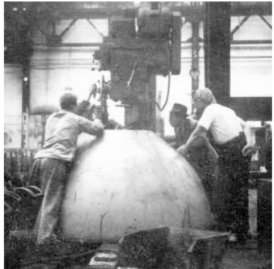
Forage des trous de fixation pour trou d'homme (à droite, en chemise blanche, le professeur Piccard).
